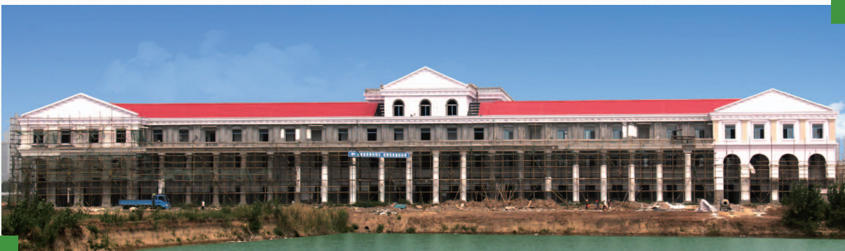
建設中的亳州新型建材項目辦公樓
