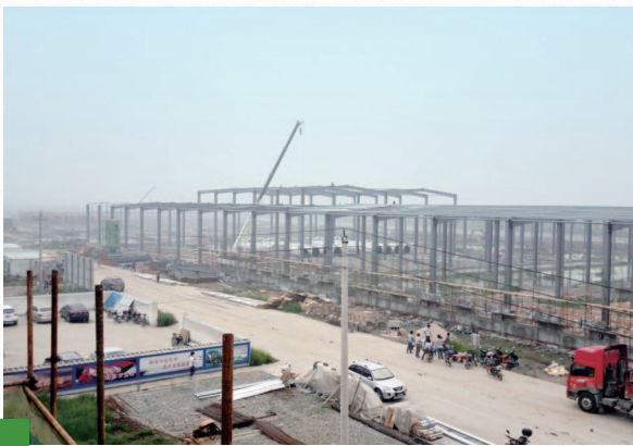
正在建設中的蕪湖新型建材項目
