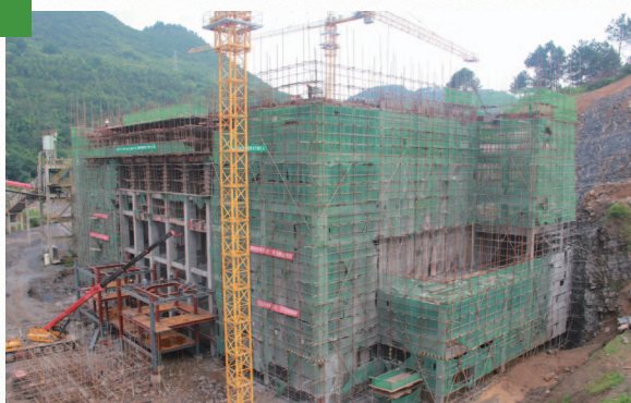
遵義市在建垃圾焚燒項目
