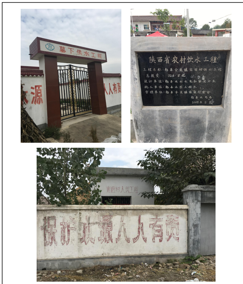
图 4.2-1 金泉镇、墓上村、拥西村供水工程
